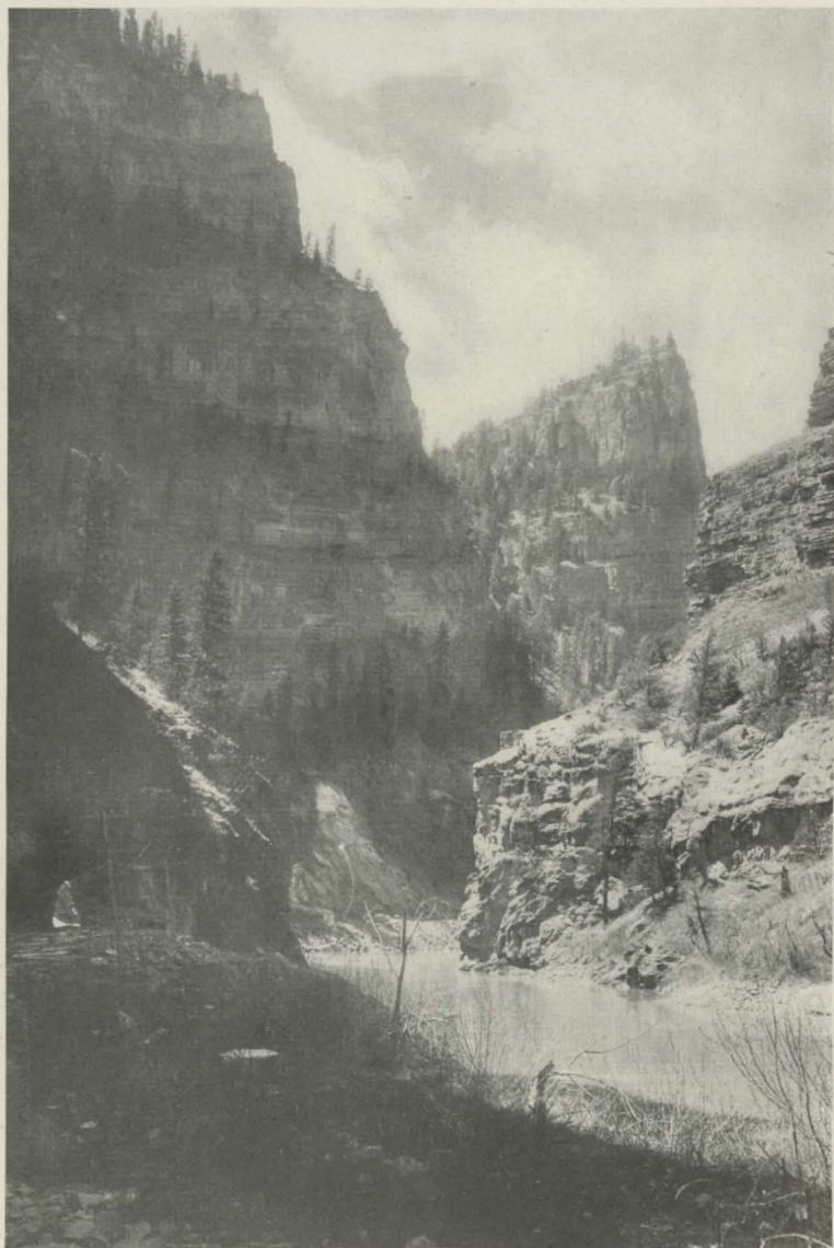
First Tunnel, Cañon of the Grand River—D. & R. G. R. R.
