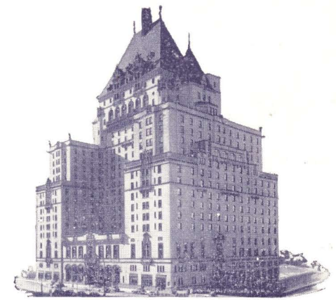
Hotel Vancouver, Vancouver, B.C.
