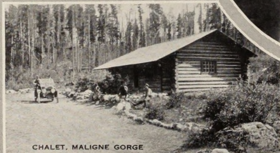
CHALET, MALIGNE GORGE
